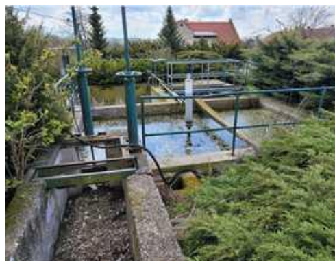
Stavba tech. vyb. ČOV na p.č. st. 27/6
