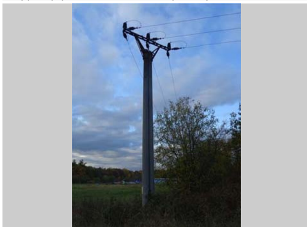
Typický pohled na mezilehlý sloup EPV 10,5-10 (dvojité); č.3
